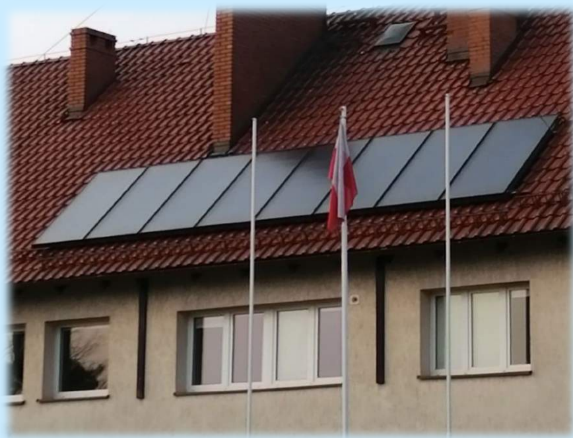
Panele fotowoltaiczne na budynku Straży Pożarnej w Pleszewie
